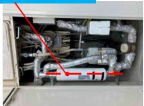
マンションのメーター部分設置
